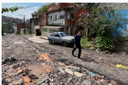
Urbanização Jd. Vitória (Em andamento)
