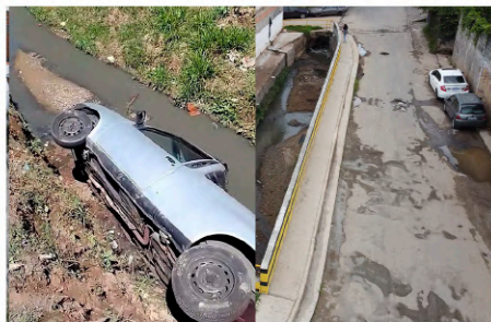
Contenção de córrego em Pirituba
